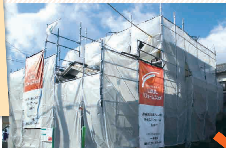
リノベーション工事中(2015年12月)
